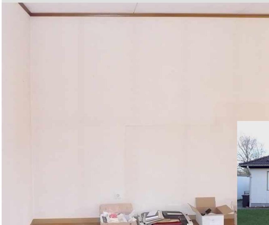
Ansicht Fertighaus Baujahr 1974 – das Ständerwerk mit vorgefertigten Wand- und Deckenelementen zeichnet sich im Innenraum wieder ab.
