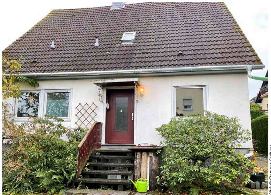
(4) Fertighaus aus den 1970er-Jahren mit Geruchsproblematik durch Chloranisole
