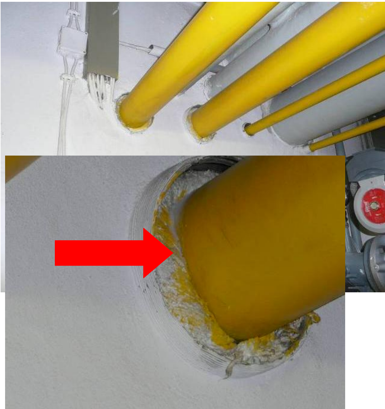
Asbest- Dichtungs- schnur
